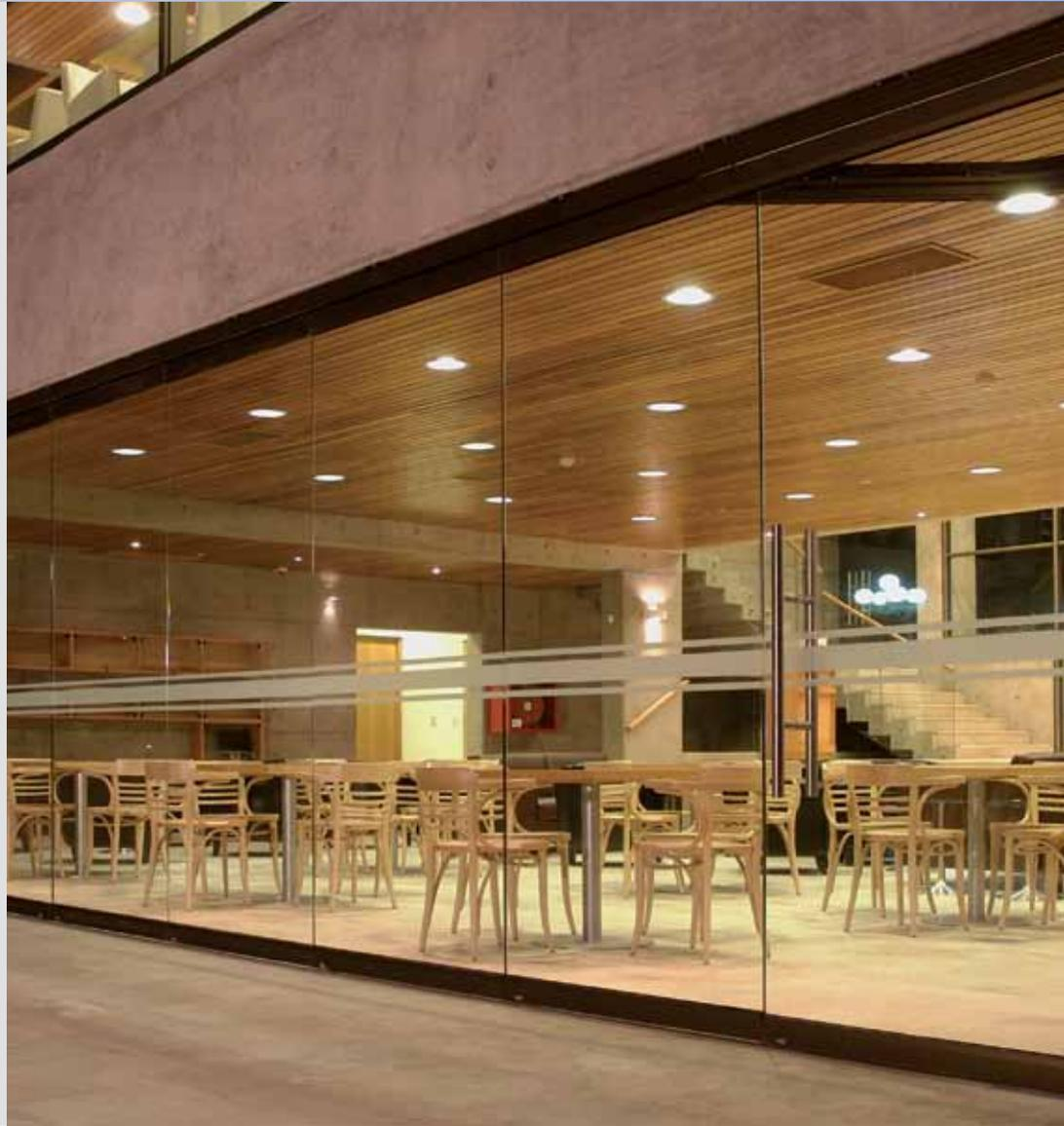
Sistema de puertas apilables para hojas de vidrio, que permite una apertura total del vano.
