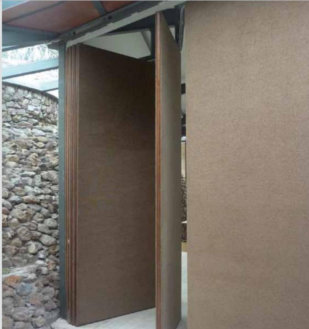
Sistema de herrajes ocultos para puertas apilables de madera de hasta 120 Kg que permite una apertura total del vano.
